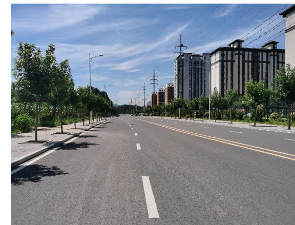
图2 泰和路道路工程
