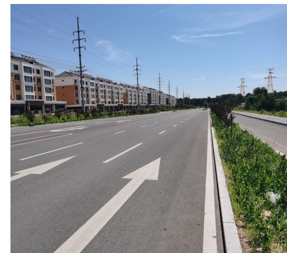
图3 永旺大街道路工程
