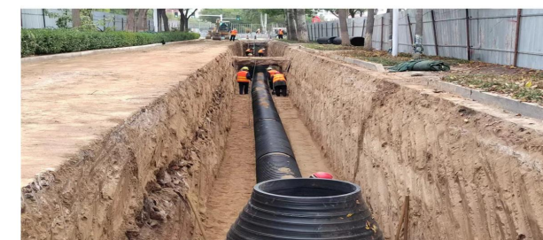
图2 管网改造施工现场
