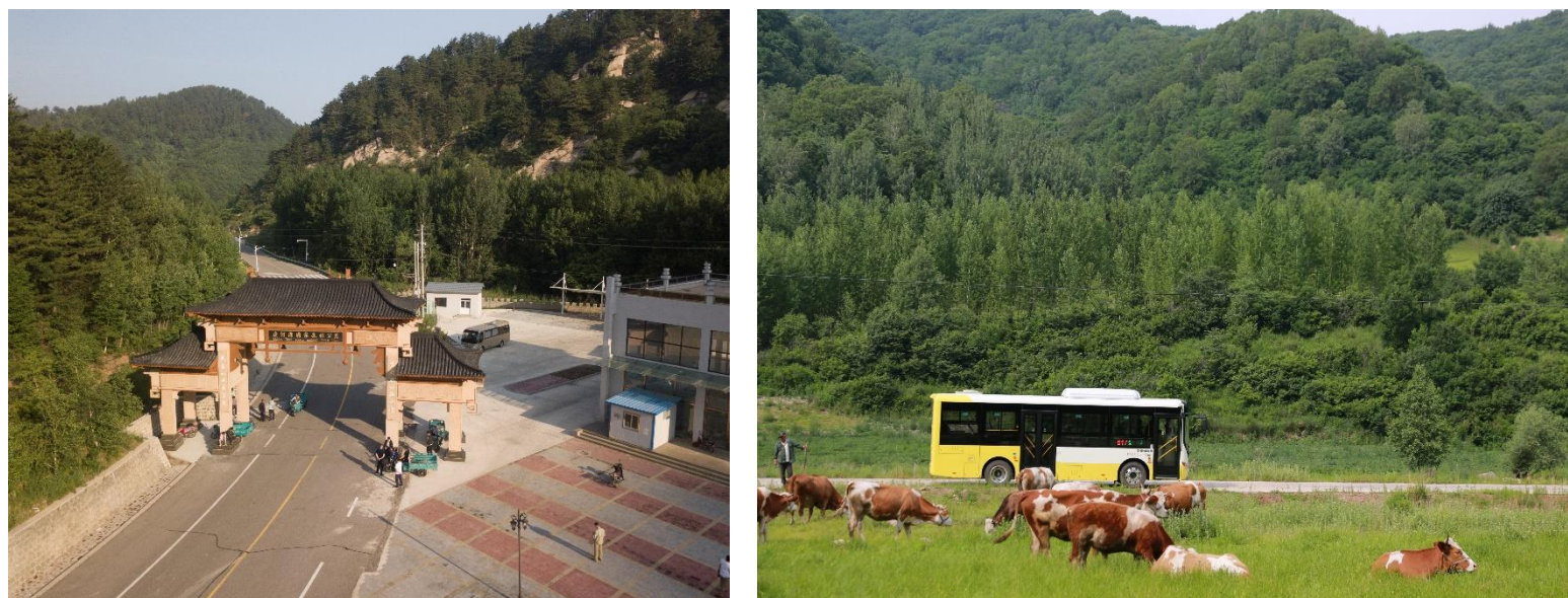
图5 农村公路建设
