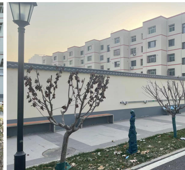
图5 北外联社家属楼改造后实景
